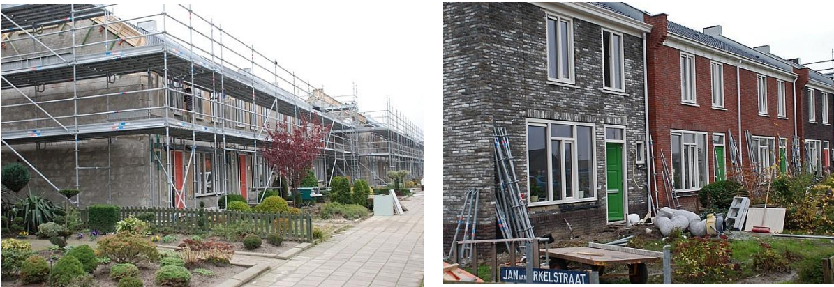
Figuur 6: gevelvervanging Poort van Vollenhove te Vollenhove
