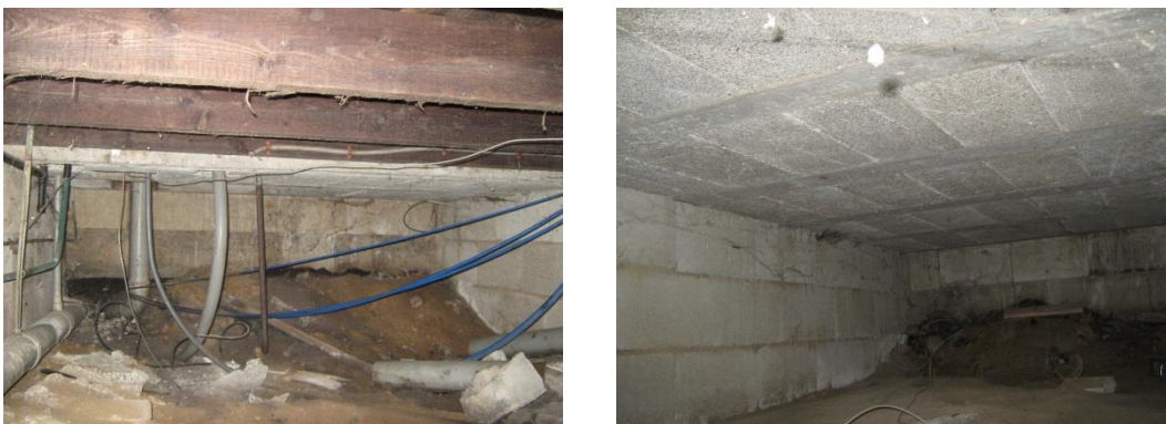
Figuur 3: onderzijde houten/beton begane grondvloer
