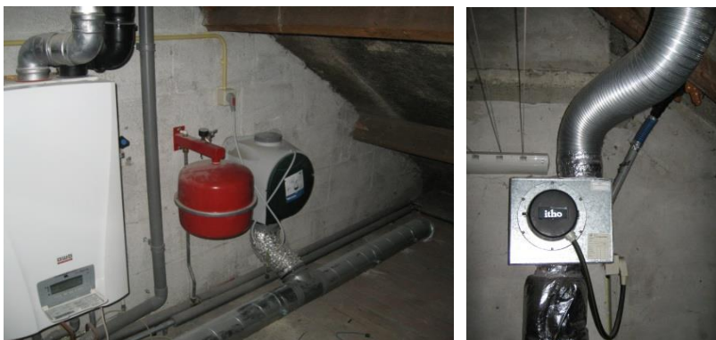
figuur 20: bestaande afzuigvoorzieningen in woning
