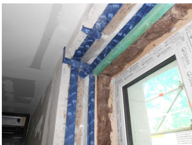
figuur 17: afdichtingen bij Passief renovatie te Enschede
