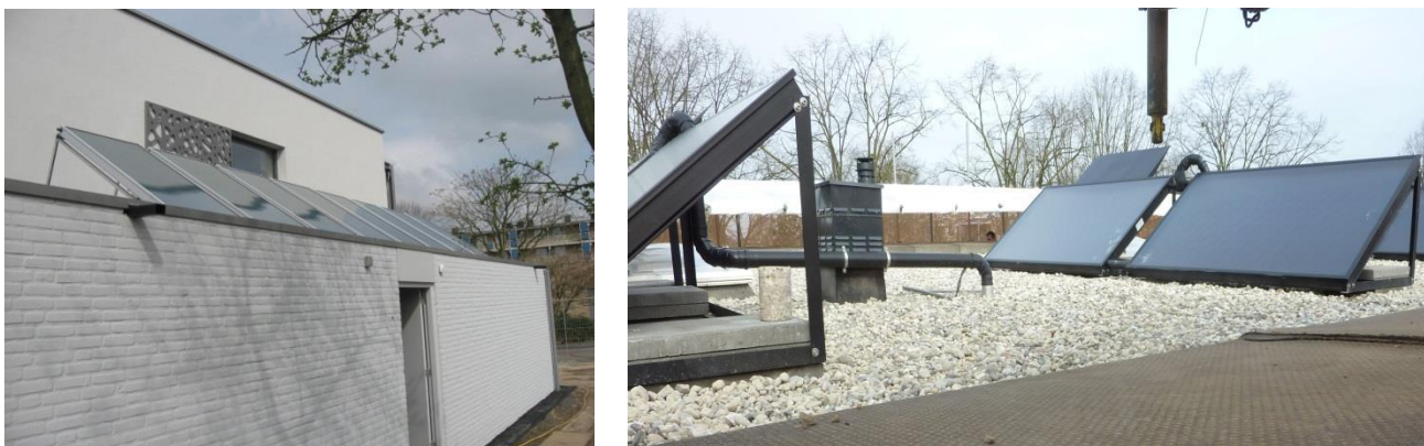
Figuur 22: voorbeeld gebruik zonnecollector bij Molenstraat en De Luttebrink-Denekampbrink
