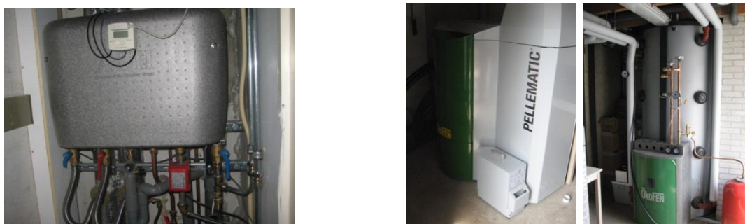
Figuur 19: Afleverzet Ankaradreef Utrecht / collectieve pelletkachel + boiler + zonneboiler bij Molenstraat
