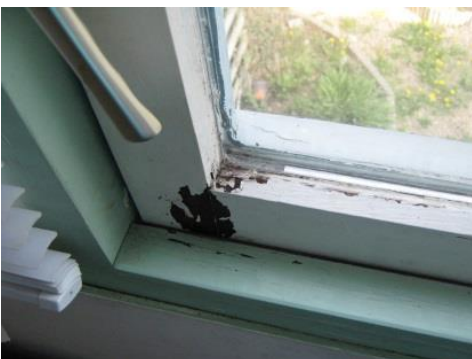
Figuur 10: bestaande houten ramen met dubbel glas
