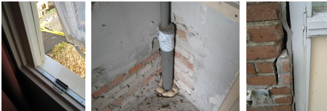
Figuur 16: luchtlekken in bestaande bouw
