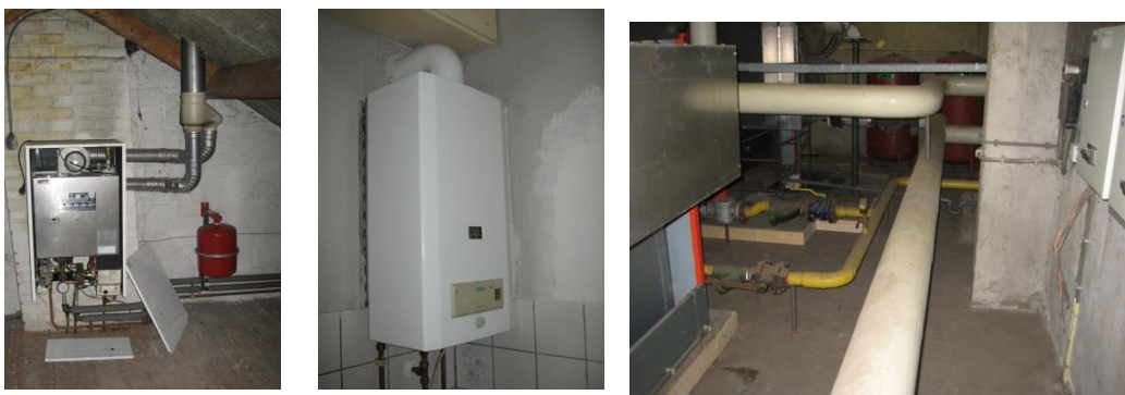
Figuur 18: bestaande VR-ketel, keukengeiser en collectieve VR-ketel
