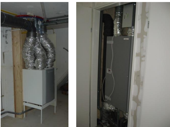
figuur 21: gebalanceerd ventilatie-unit, na uitvoering van Passief renovatie
