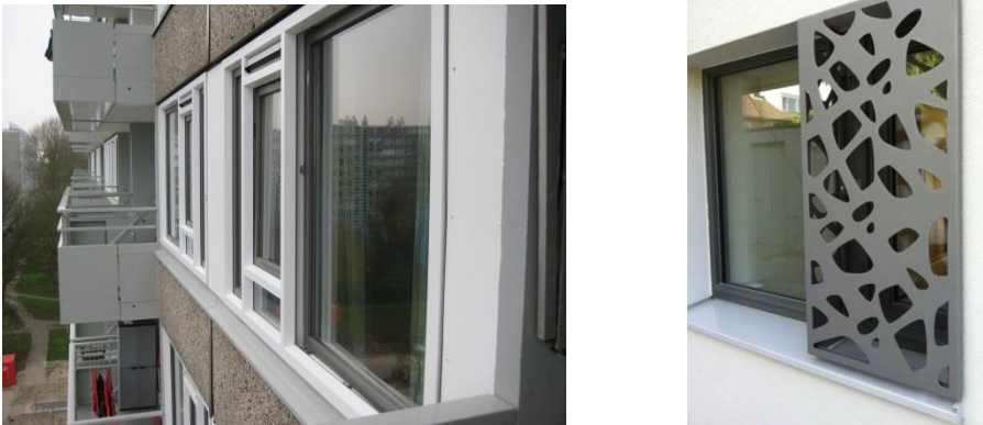
Figuur 12: nieuwe kunststof kozijnen met HR++-glas Ankaradreef te Utrecht en een Passief kozijn met triple glas bij Molenstraat te Vught
