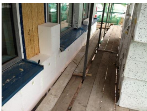
Figuur 8: voorbeeld nieuw geïsoleerd buitenspouwblad bij De Luttebrink-Denekampbrink
