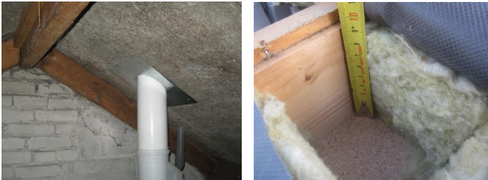
Figuur 14: bestaande dakconstructies
